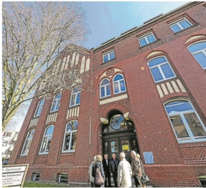
Das Schulmuseum in einem historischen Schulgebäude in Marten soll saniert und neu konzipiert werden. FOTO (A) SCHÜTZE
