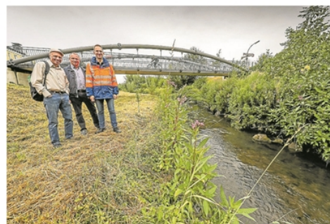
Komplett umgestaltet ist die Emscher im Bereich am Mühlberg. Die neue Brücke ist deutlich höher und bietet so im Hochwasserfall mehr Durchfluss.
