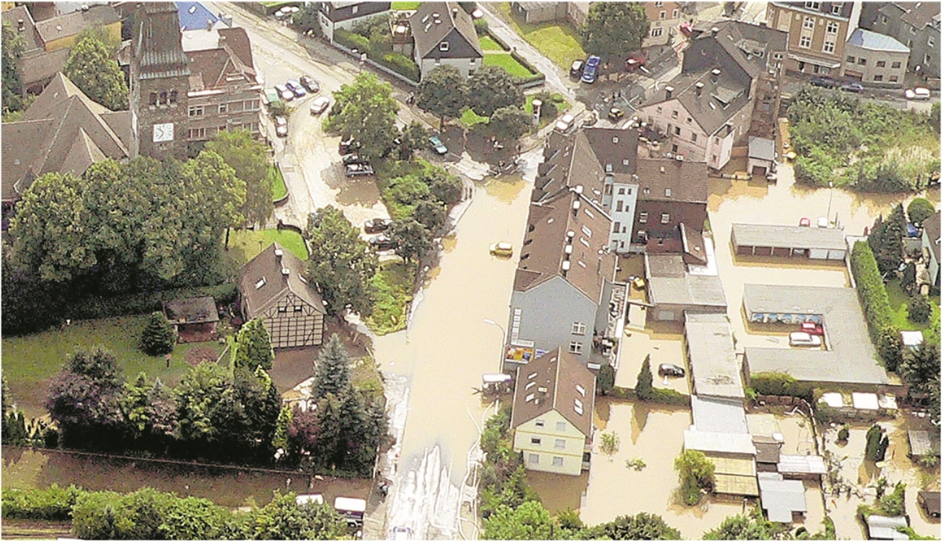
So sah es nach dem großen Unwetter vom 26. Juli 2008 im Zentrum von Marten aus. Straßen und Häuser standen meterhoch unter Wasser.
